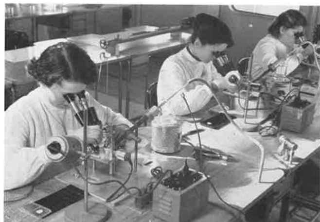
En trois soudures très précises opérées sous binoculaire, on réunit émetteur, base et collecteur aux connexions correspondantes.
