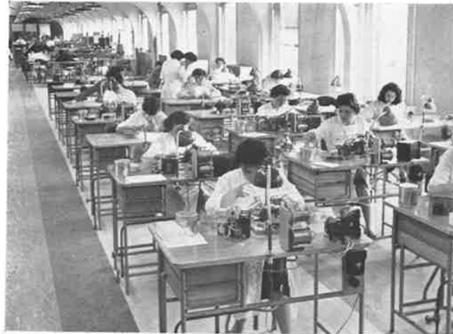
Vue intérieure d'un atelier de l'Usine.
